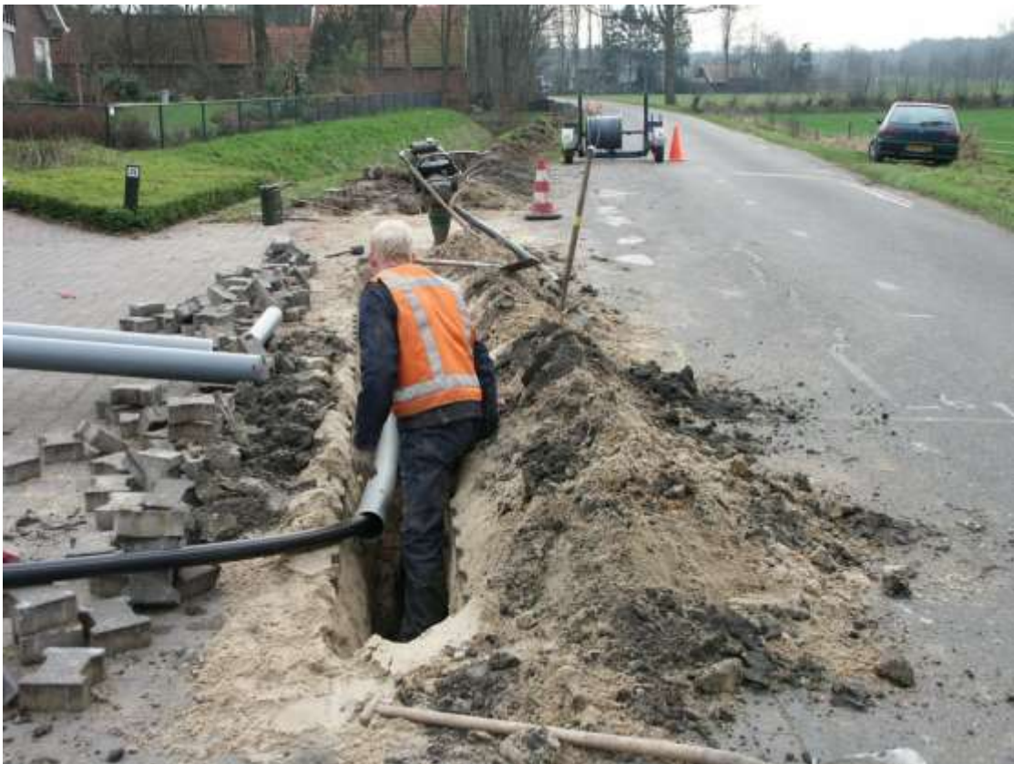
Aanleg drukriolering buitengebied
