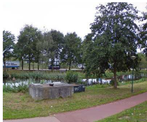
foto ontvangput aan de Koningsweg
